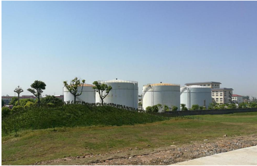
依托国星公司 5000m 3 事故应急罐
